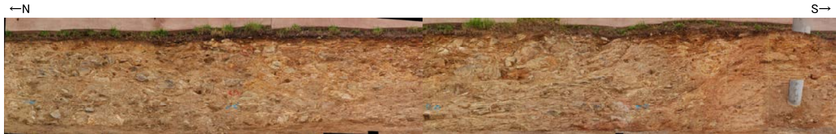
写真(35m盤法面)
