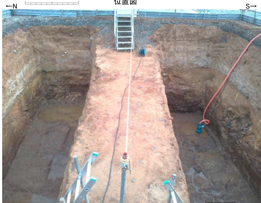
トレンチ状況写真(西側から撮影)
