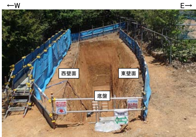
トレンチ状況写真(南側から撮影)
