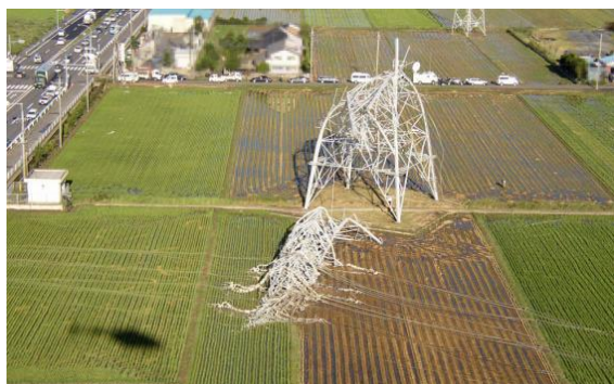
強風による送電鉄塔の倒壊事例① ※1
