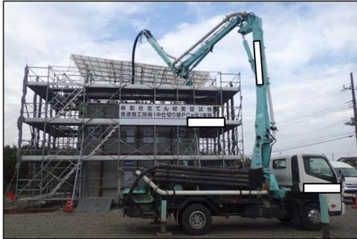
第 23 図 モルタル打設方法
