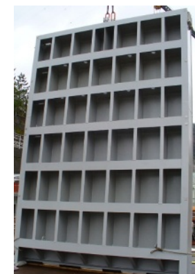
【取水路下流側から見たゲート扉体】
