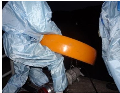
水中ポンプ設置準備（夜間）
