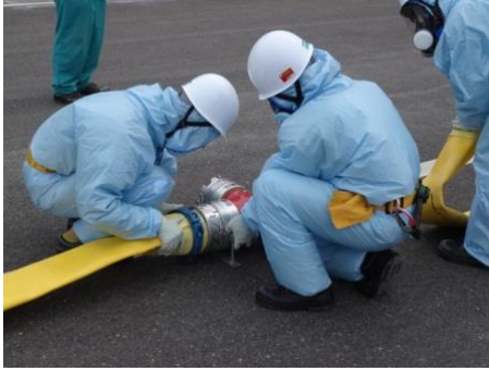
ホース接続作業（昼間）
