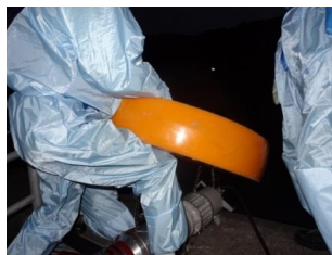
水中ポンプ設置準備（夜間）
