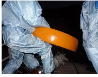
水中ポンプ設置準備（夜間）
