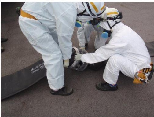
ホース接続作業
