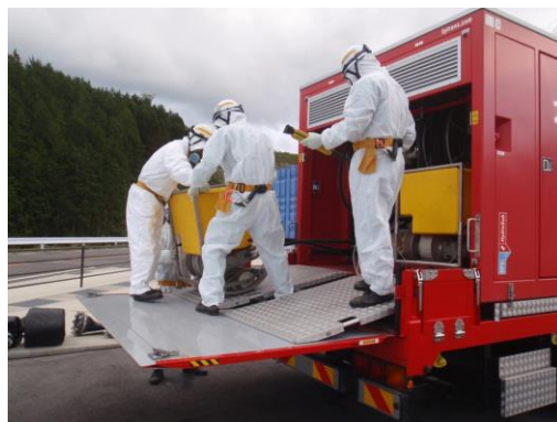
水中ポンプ設置準備
