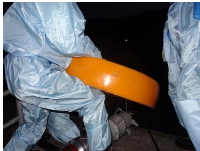
水中ポンプ設置準備（夜間）
