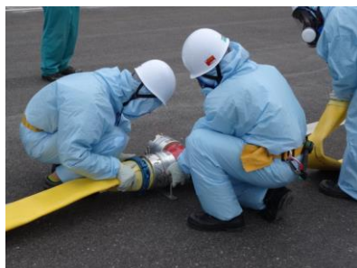
ホース接続作業（昼間）
