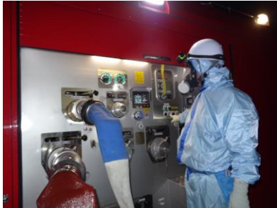
ポンプ起動操作（夜間）
