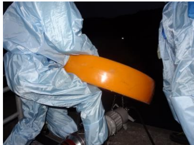
水中ポンプ設置準備（夜間）
