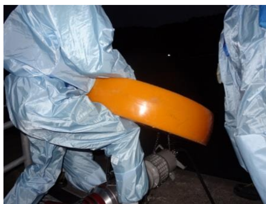
水中ポンプ設置準備（夜間）
