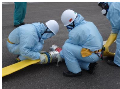
ホース接続作業（昼間）
