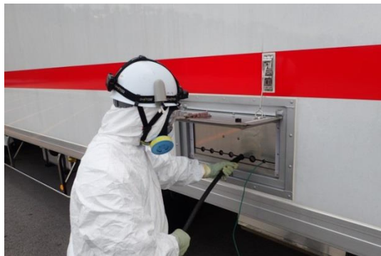
ケーブル接続作業
