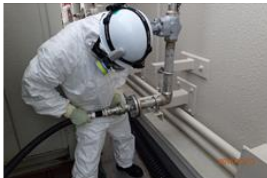
ホース接続作業
