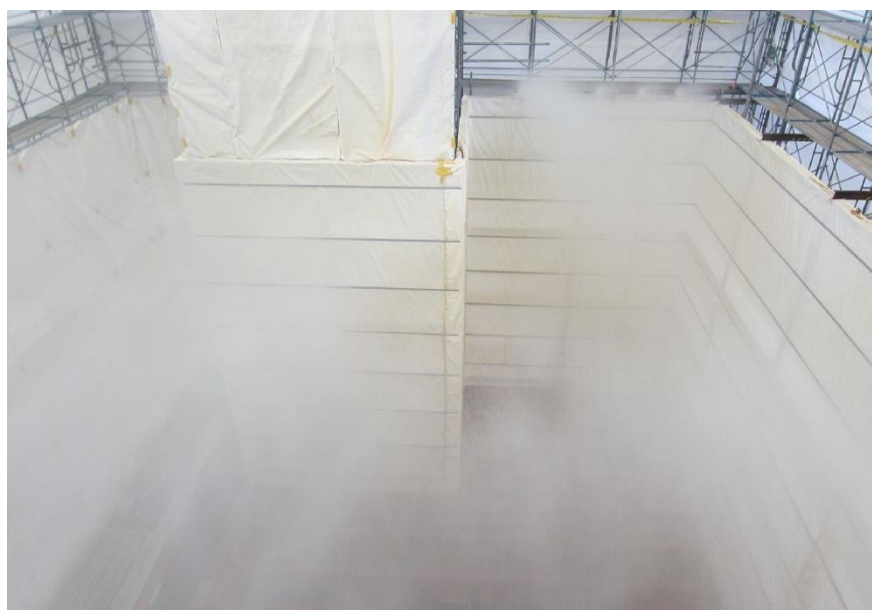
図8 スプレー時の試験状況（スプレー量：120m 3 /h）
