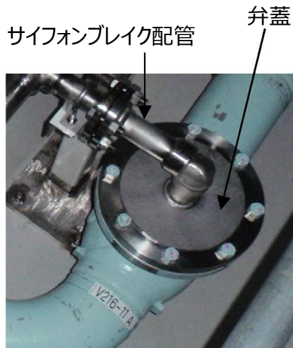
図17-2 逆止弁外観
