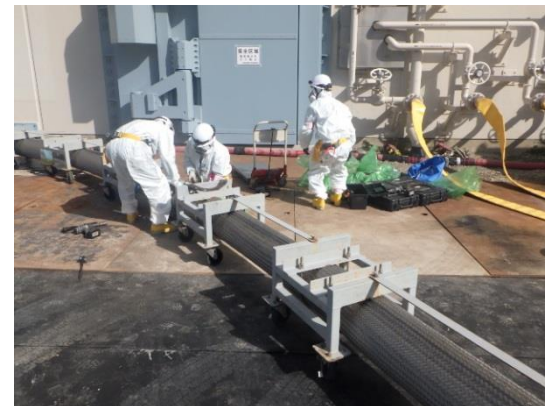
移動式代替熱交換設備 (EL15m 西側接続口付近)
