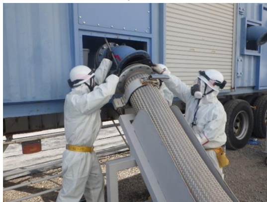
移動式代替熱交換設備 (EL15m 西側接続口付近)
