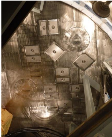
図3 コリウムシールド外観
