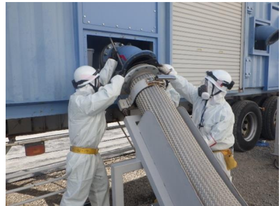
移動式代替熱交換設備 (15m盤 西側接続口付近)
