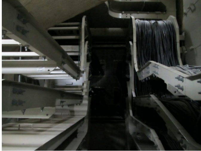
図3① ケーブルダクト室内 MCT 付近
