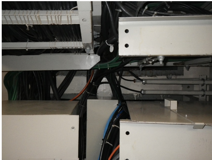
図6 貫通部写真（原子炉建家側視点）
