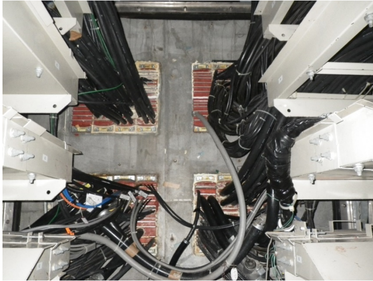
図5 貫通部写真（ケーブルダクト室側視点）
