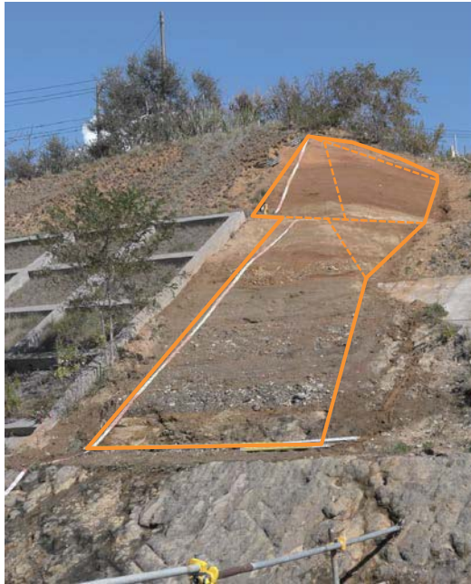
露頭状況写真
