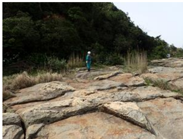
図 2 - 8 ( 3 ) 防波壁 ( 東端部 ) 露頭状況 P3 地山北端部 火山礫凝灰岩 C_H 級
