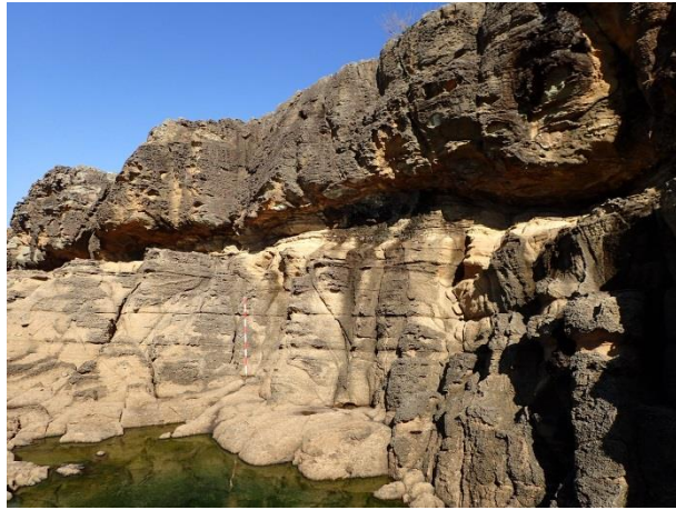
図2-8(4) 防波壁(東端部)露頭状況 P4 防波壁東側ほぼ垂直な崖 火山礫凝灰岩 C H 級
