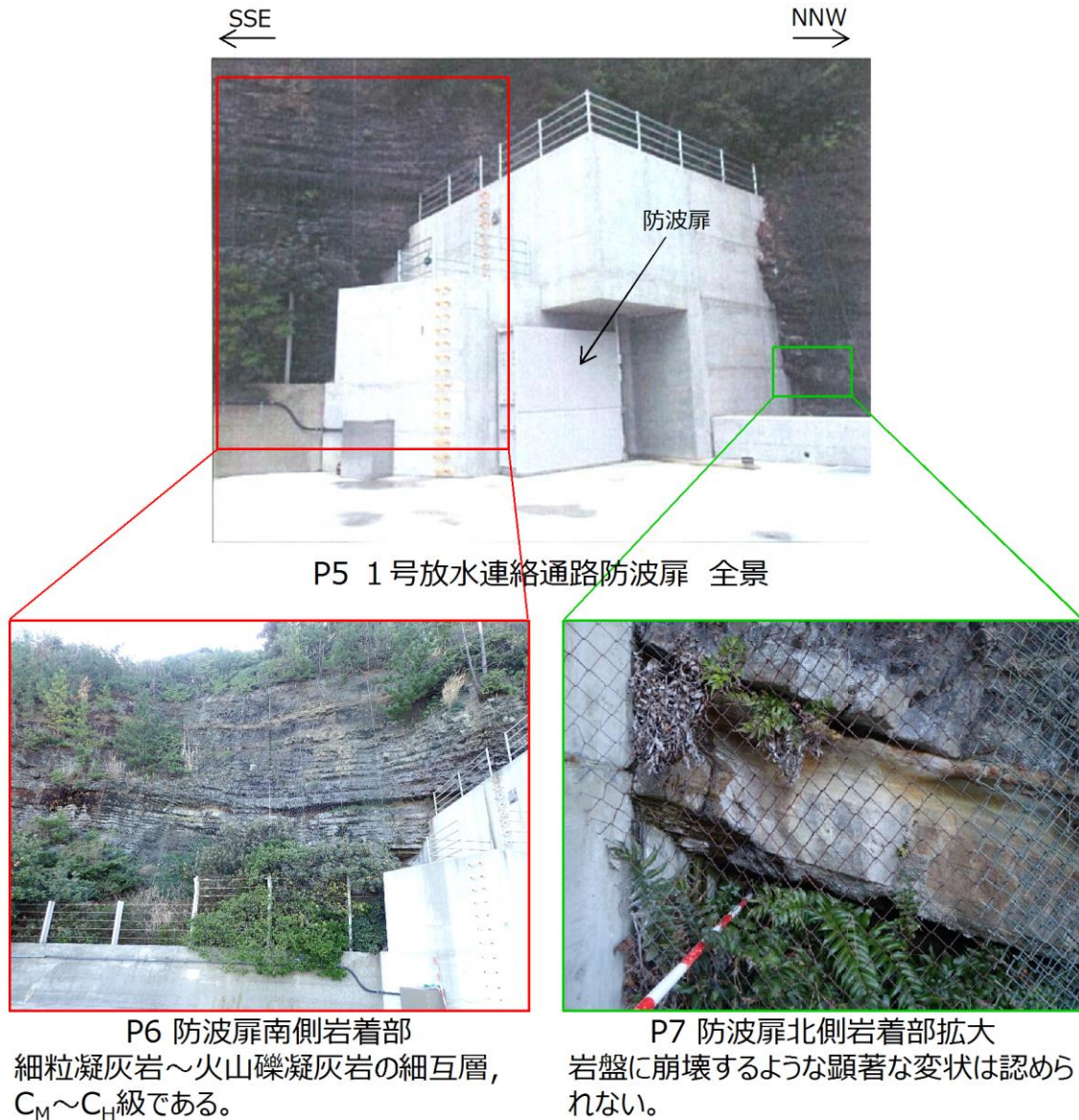
図2-10 1号放水連絡通路防波扉 状況写真
