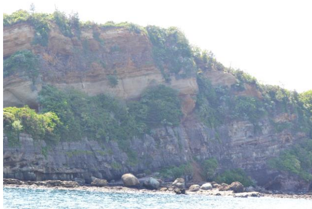
図2-12(7) 防波壁(西端部)露頭状況 P7 岬西側の崖 主にC M ~C H 級からなる岩盤が切り立った崖をなす。
