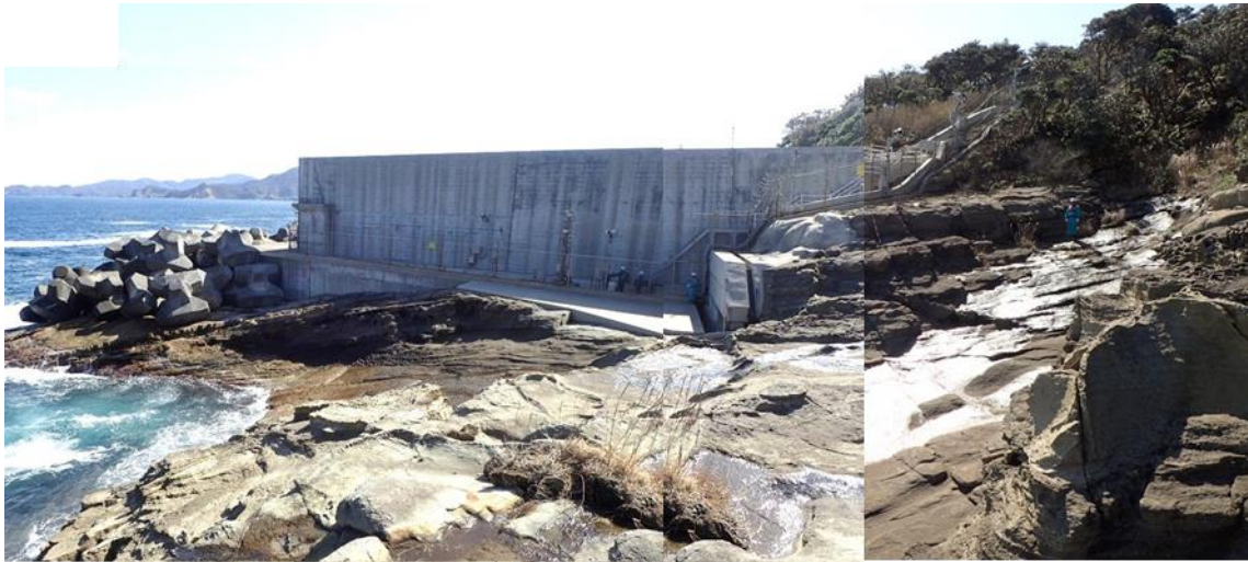
図 2-12 (1) 防波壁 (西端部) 露頭状況 P1 防波壁西端部全景 岩着部は火山礫凝灰岩, C_M \sim C_H 級岩盤からなる。
