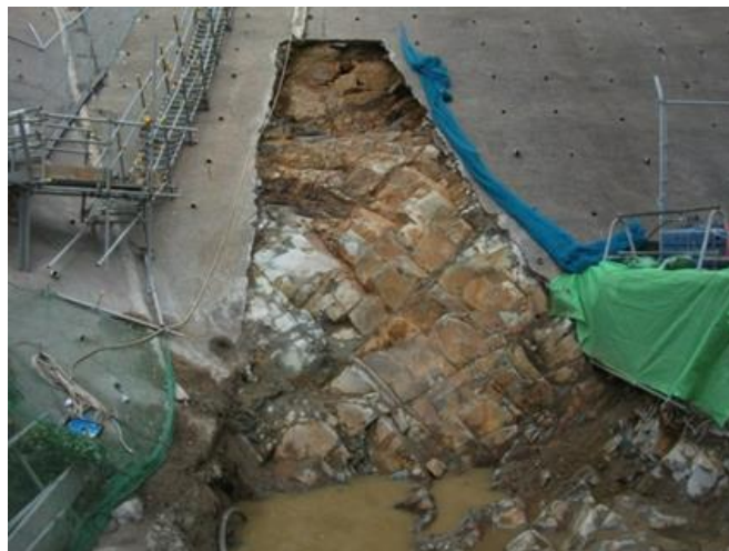
図 2 - 31 防波壁東端部 岩盤露出状況
