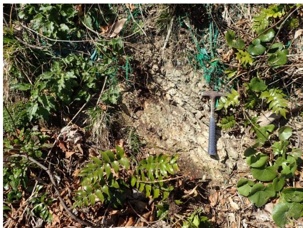
図 2-12 (4) 防波壁 (西端部) 露頭状況 P4 尾根部露頭 火山礫凝灰岩 C L 級
