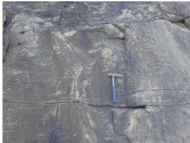
図 2-12 (2) 防波壁 (西端部) 露頭状況 P2 防波壁西端部 火山礫凝灰岩 C_H 級
