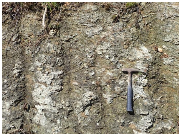
図 2-12 (5) 防波壁 (西端部) 露頭状況 P5 斜面露頭 火山礫凝灰岩 C L 級
