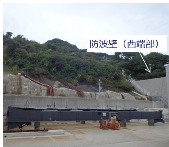
図 2 - 33 防波壁西端部 状況写真
