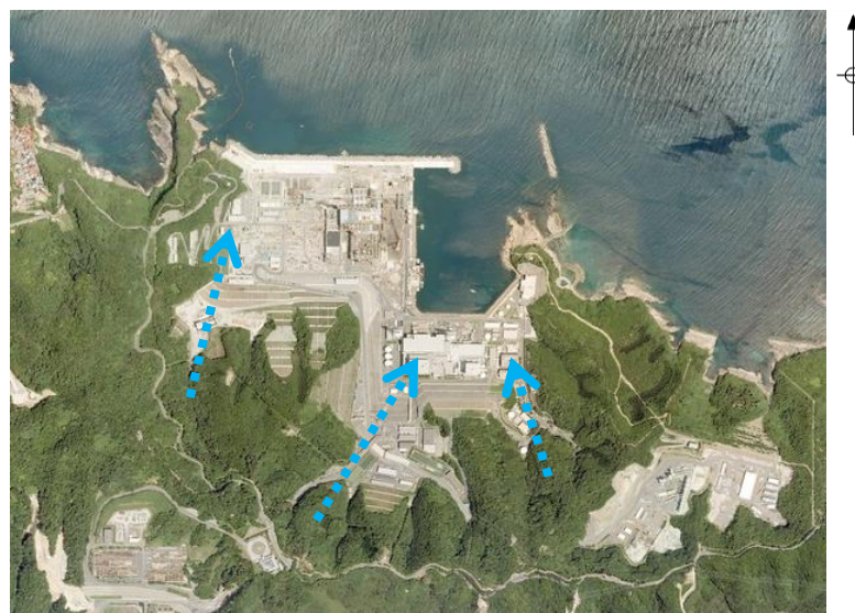
.....➡ 主な地表水の流れ 島根原子力発電所周辺の空中写真 出典：国土地理院（2009年撮影）
