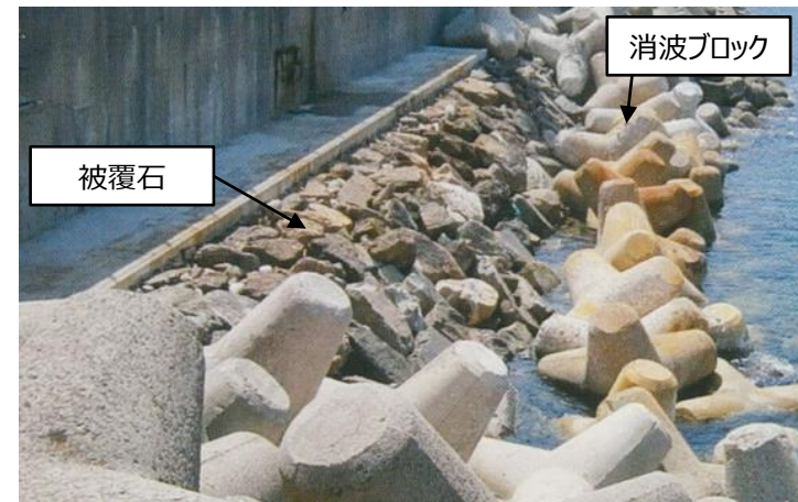
被覆石設置状況（1, 2号炉北側護岸）
