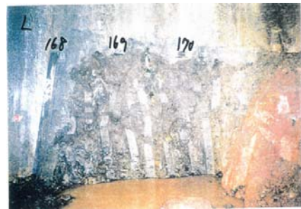
側壁(下半南側)No.168~170 写真
