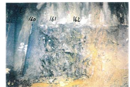
側壁(下半南側)No.160~162 写真
