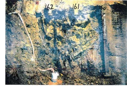
側壁(下半北側)No.160~162 写真
