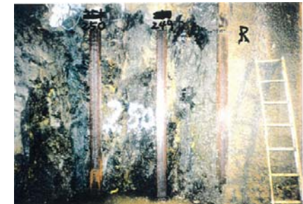
側壁(下半北側)No.249~250 写真
