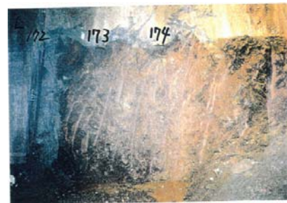
側壁(下半南側)No.172~174 写真
