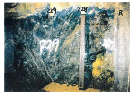
側壁(下半北側)No.228~229 写真
