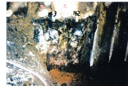
側壁(下半北側)No.142~143 写真
