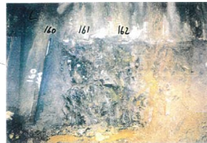
側壁(下半南側)No.160~162 写真
