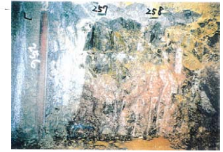
側壁(下半南側)No.257~258 写真
