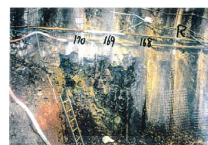
側壁(下半北側)No.168~170 写真
