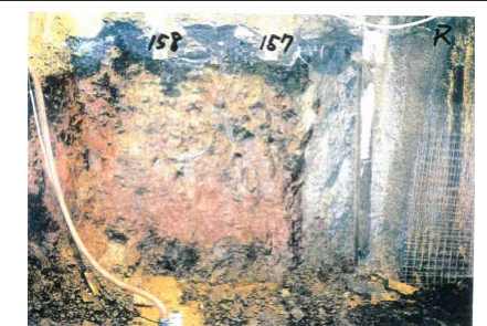
側壁(下半北側)No.157~158 写真
