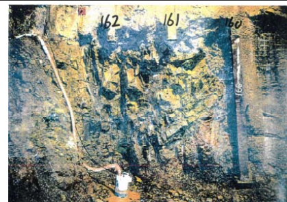
側壁(下半北側)No.160~162 写真
