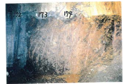
側壁(下半南側)No.172~174 写真
