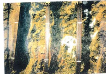
側壁(下半南側)No.179~180 写真
