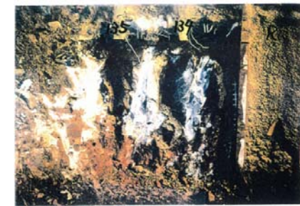
側壁(下半北側)No.134~135 写真
