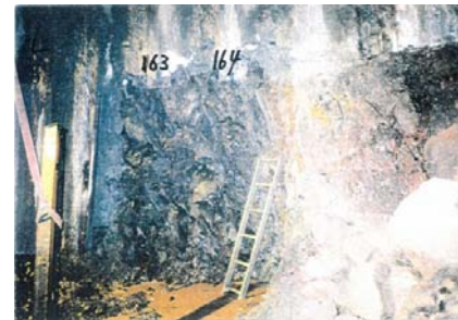
側壁(下半南側)No.163~164 写真
