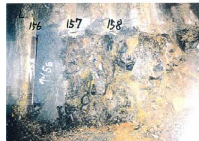
側壁(下半南側)No.156~158 写真
