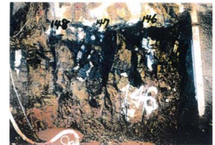
側壁(下半北側)No.146~148 写真
