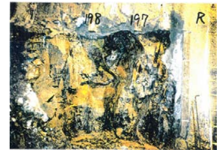
側壁(下半北側)No.197~198 写真
