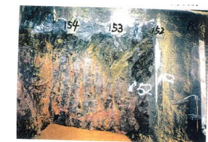
側壁(下半北側)No.152~154 写真
