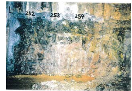
側壁(下半南側)No.252~254 写真
