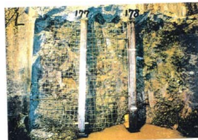
側壁(下半南側)No.177~178 写真
