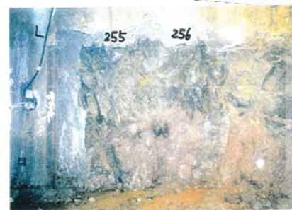
側壁(下半南側)No.255~256 写真
