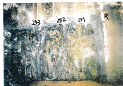
側壁(下半北側)No.251~253 写真
