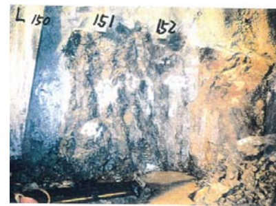
側壁(下半南側)No.150~152 写真
