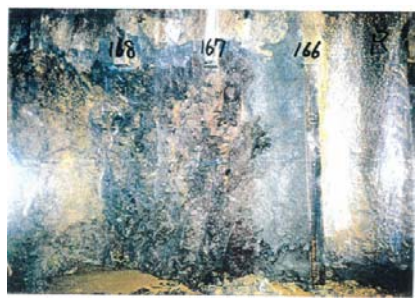
側壁(下半北側)No.166~168 写真
