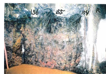
側壁(下半北側)No.154~156 写真
