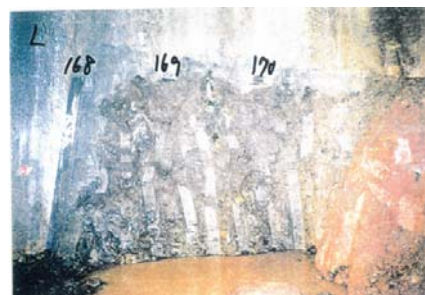
側壁(下半南側)No.168~170 写真
