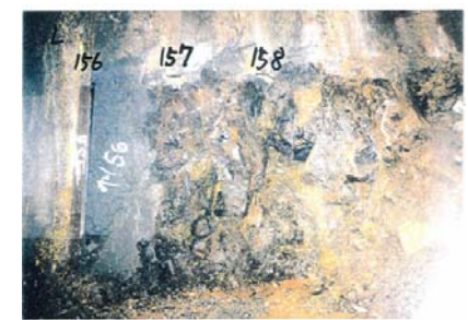
側壁(下半南側)No.156~158 写真
