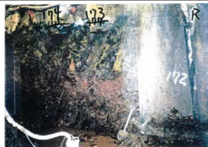
側壁(下半北側)No.174~173 写真
