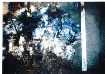
側壁(下半北側)No.140~141 写真
