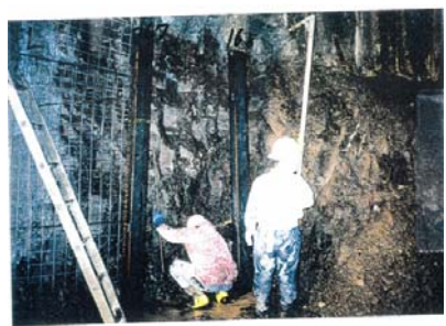
側壁(下半南側)No.167~168 写真
