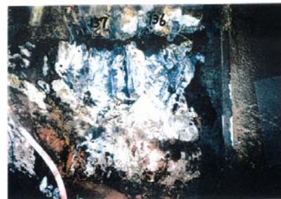
側壁(下半北側)No.136~137 写真
