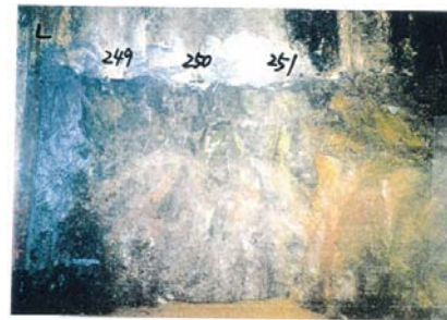
側壁(下半南側)No.249~251 写真
