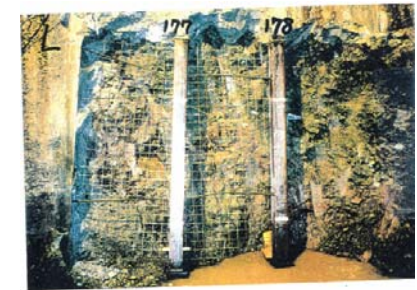
側壁(下半南側)No.177~178 写真
