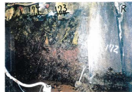
側壁(下半北側)No.173~174 写真
