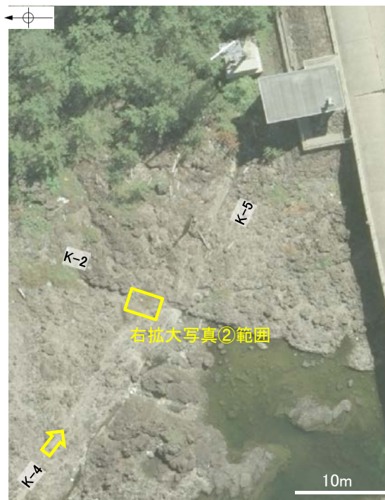
拡大写真① K-4の南東方付近
