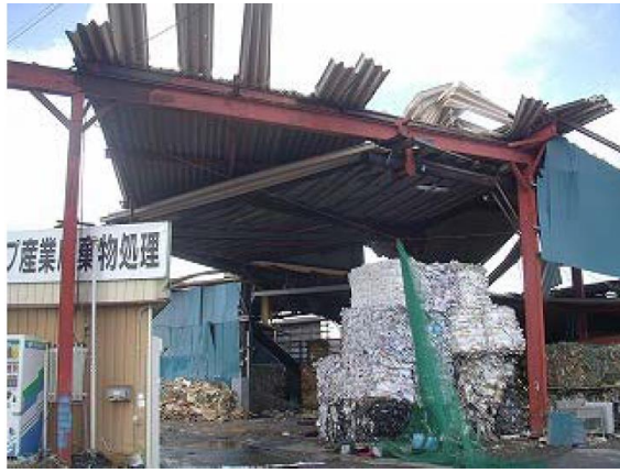
折板の損傷
