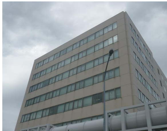
第13図 敷地内におけるガラス窓の状況
