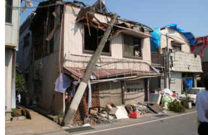
倒壊電柱に直撃された家屋
