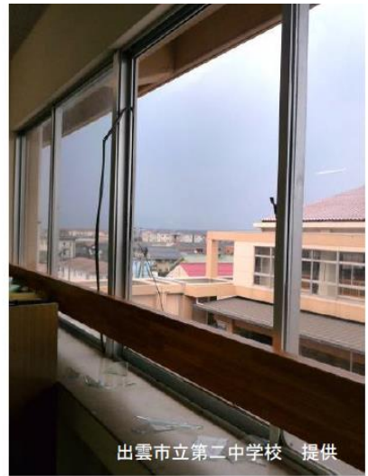
屋外に面した窓ガラス
