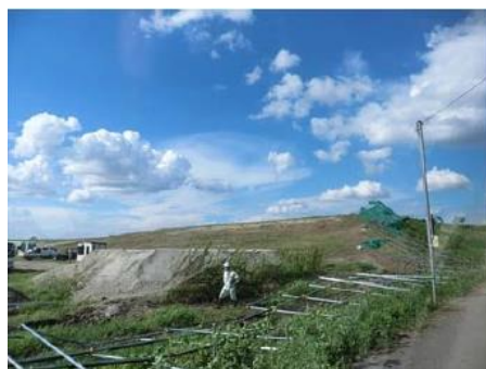
フェンスの倒壊
