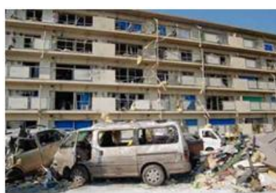
飛来物により被害を受けた住宅等
