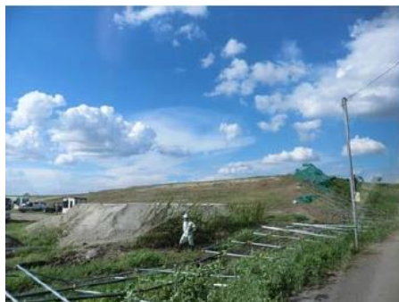
フェンスの倒壊
