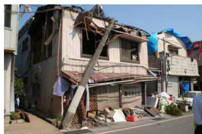
倒壊電柱に直撃された家屋
