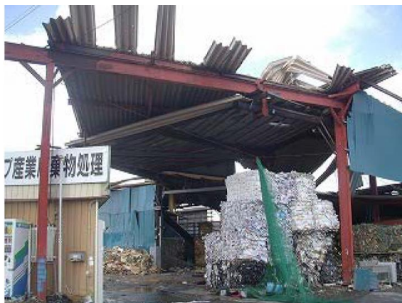
折板の損傷
