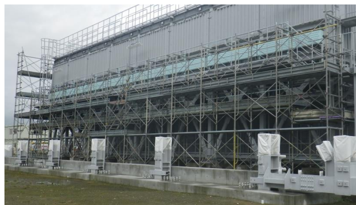
第5-4-33図 再処理事業所における仮設足場の状況
