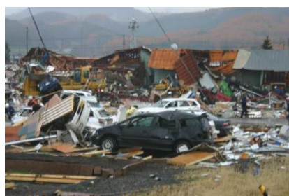
全壊した工事事務所周辺
