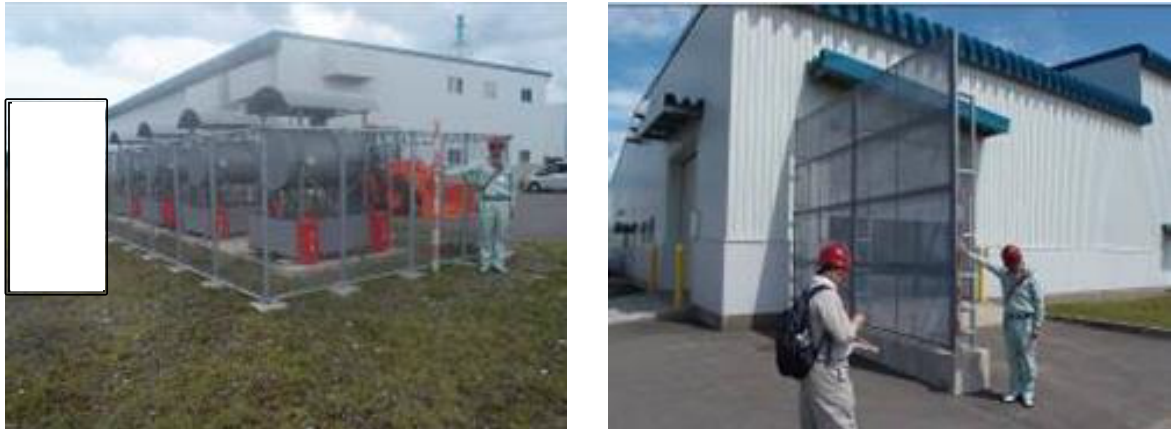
第5-4-32図 再処理事業所におけるフェンスの状況
