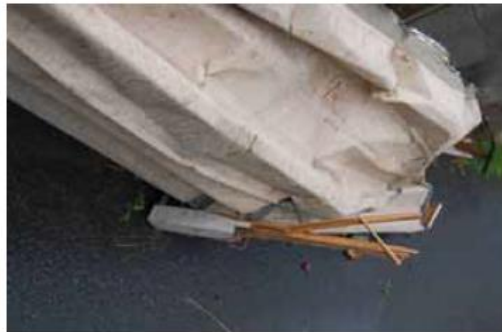
飛散した折板屋根の損傷状況
