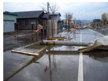
道路側へ倒壊した電柱
