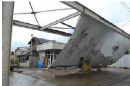
ガソリンスタンドの折板屋根の脱落 駐車場の折板屋根の著しい変形
