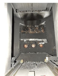
盤内開口部の状態(遮断器室)
