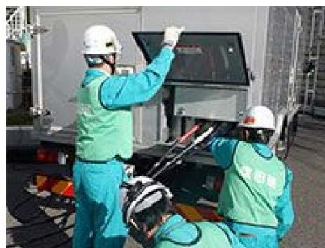
高圧発電機車を用いた電源供給訓練の状況 （写真は全交流電源喪失時を想定した電源ケーブル接続作業）
