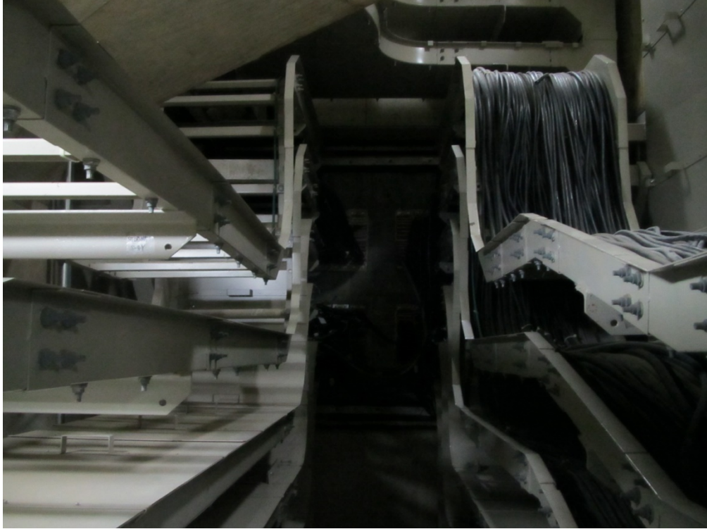
図 2① ケーブルダクト室内 MCT 付近
