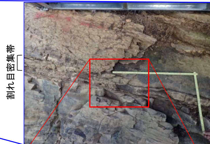
凝灰岩露頭写真
