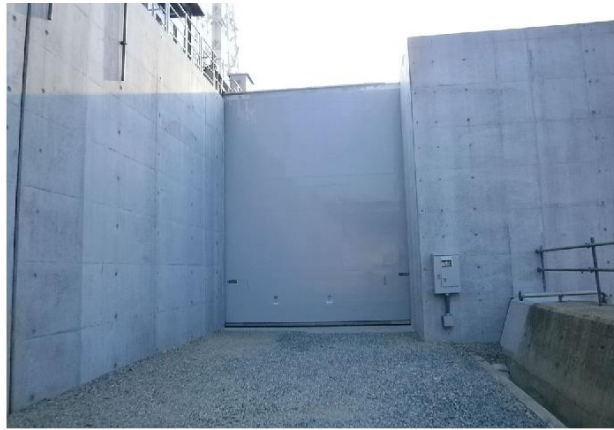
第 1-46 図 防波壁通路防波扉（1，2号炉北側）③ 設置状況
