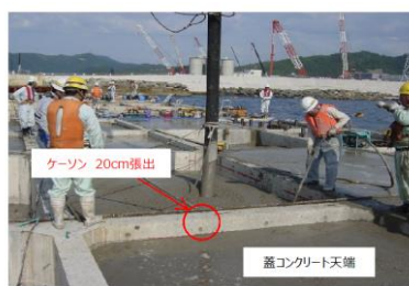
蓋コンクリート打設状況
