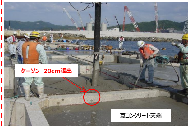
蓋コンクリート打設状況
