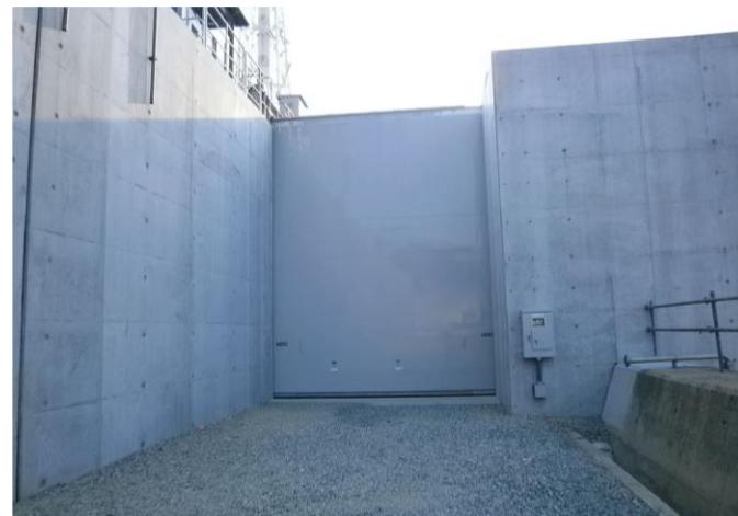
③防波壁通路防波扉（1, 2号炉北側） 設置状況
