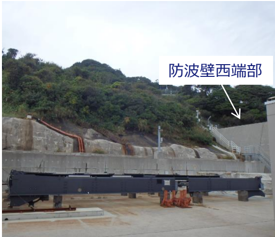
防波壁西端部 状況写真
