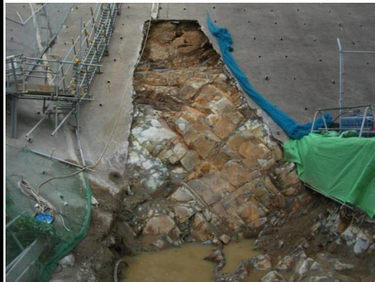
防波壁東端部 岩盤露出状況
