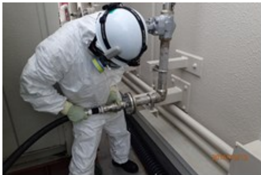
ホース接続作業
