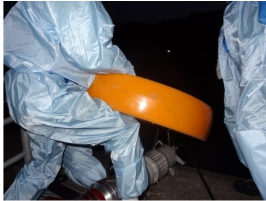
水中ポンプ設置準備（夜間）
