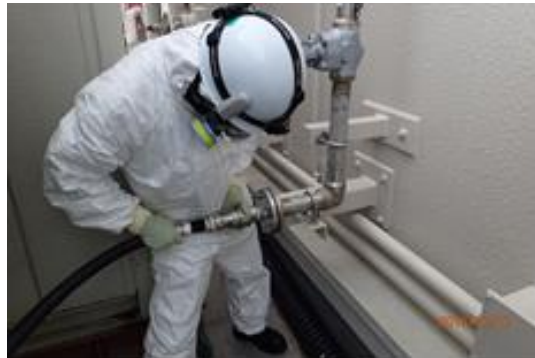
ホース接続作業
