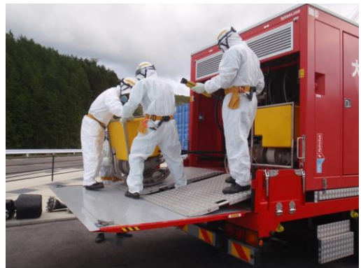
水中ポンプ設置準備
