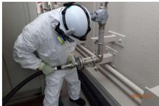
ホース接続作業
