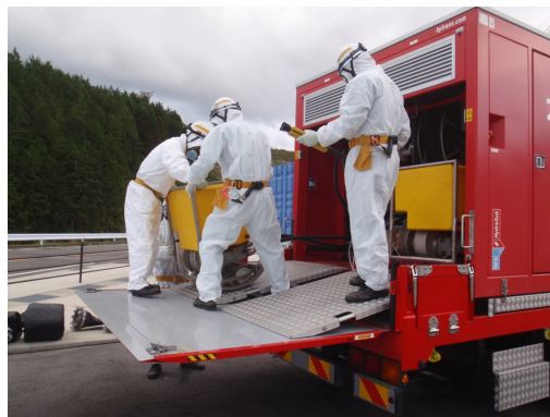
水中ポンプ設置準備
