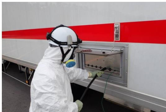
ケーブル接続作業
