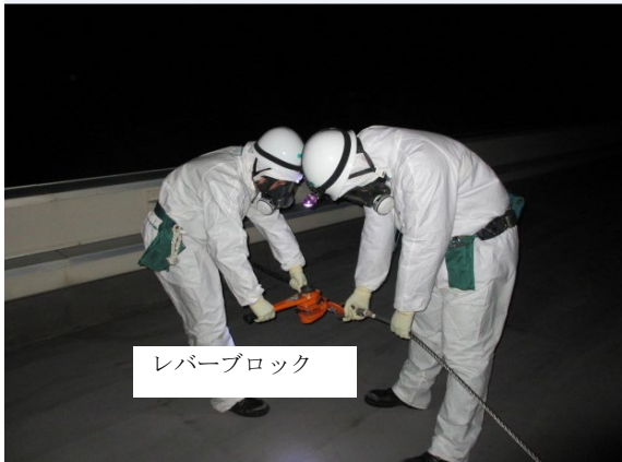
ワイヤー，レバーブロック接続作業
