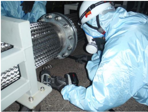
ホース接続作業
