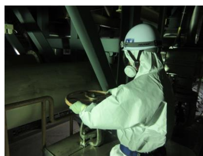
冷却水確保（系統構成）
