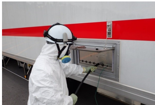
ケーブル接続作業
