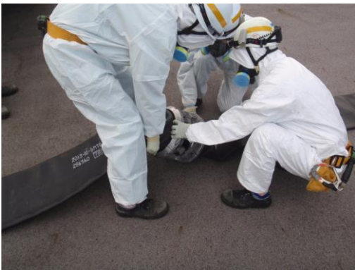
ホース接続作業
