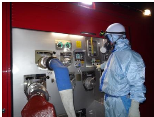
ポンプ起動操作 (夜間)
