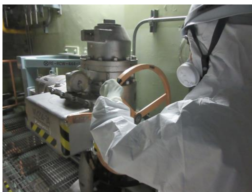
冷却水確保（系統構成）
