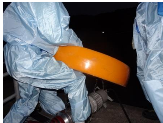
水中ポンプ設置準備 (夜間)
