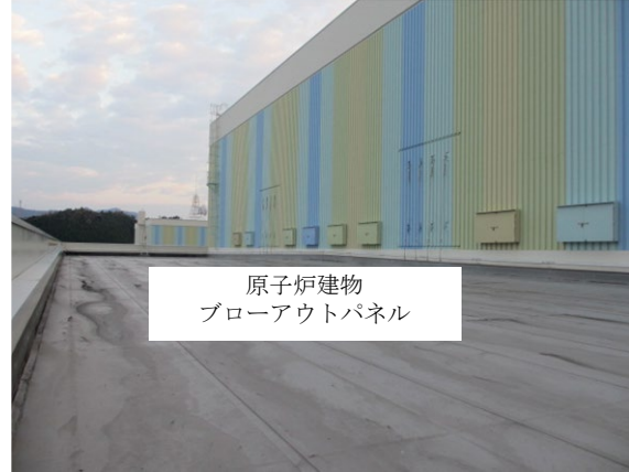
原子炉建物ブローアウトパネル
