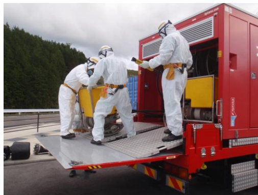
水中ポンプ設置準備
