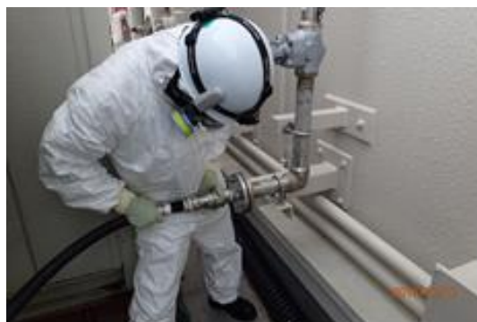
ホース接続作業
