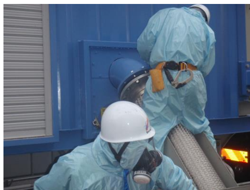
移動式代替熱交換設備へのホース接続作業
