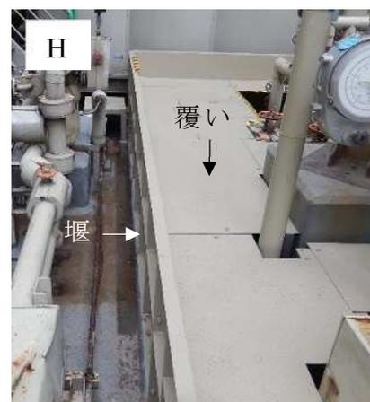
図3 堰周りの状況（3号塩酸貯槽、アンモニア貯槽、ヒドラジン原液タンク）
