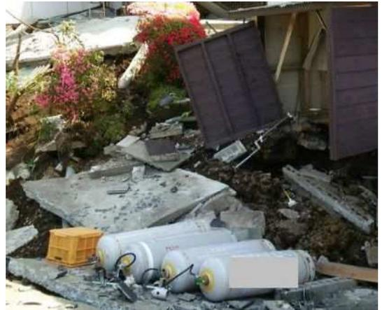
熊本地震での LP ガスボンベの被災状況の一例<sup>3)</sup>
