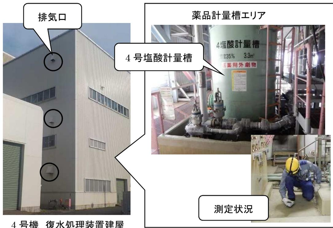
図1 建屋内風速の測定例（4号機 復水処理装置建屋）
