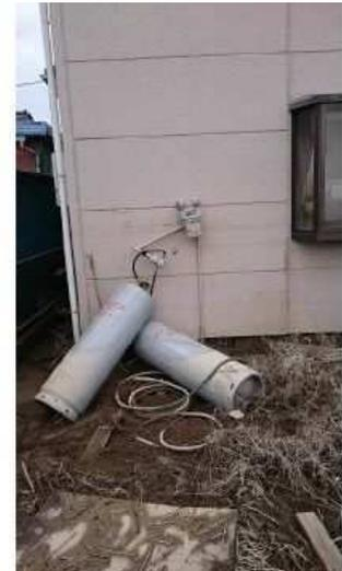
東日本豪雨（常総市の水害）での LP ガスボンベの被災状況の一例<sup>3)</sup>
