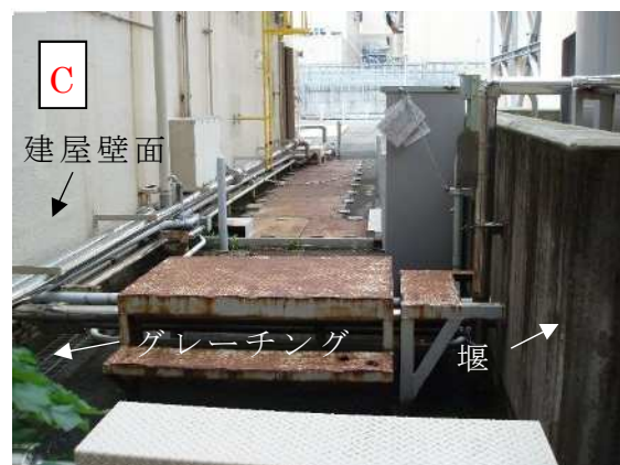
図9 堰周りの状況 (2号ヒドラジン原液タンク)
