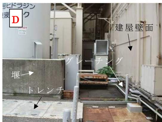
図9 堰周りの状況 (2号ヒドラジン原液タンク)
