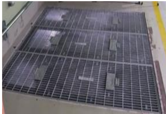
図1-2 トラス室上部ハッチ
