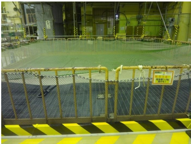
図1-1 原子炉建物大物搬入口
