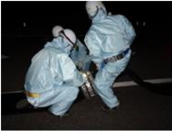
ホース接続作業（夜間）
