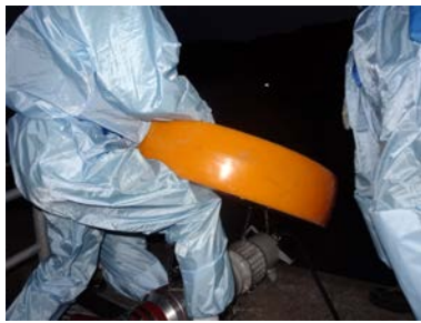
水中ポンプ設置準備（夜間）
