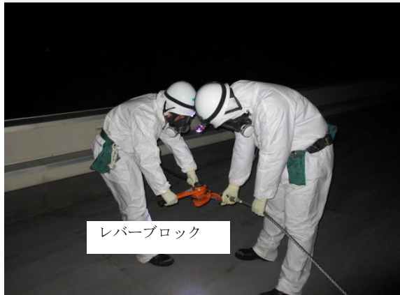
ワイヤー，レバーブロック接続作業
