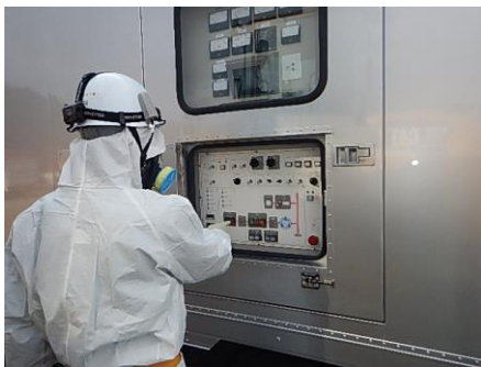
高圧発電機車での作業
