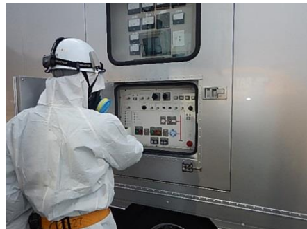
高圧発電機車での作業
