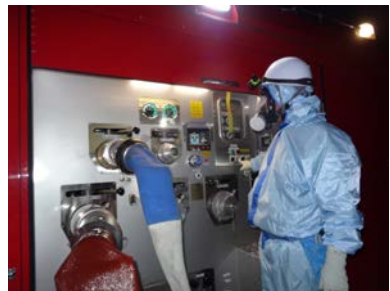
ポンプ起動操作（夜間）
