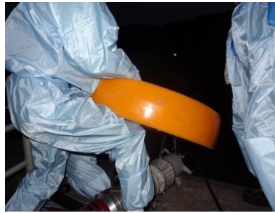
水中ポンプ設置準備（夜間）
