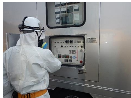
高圧発電機車での作業
