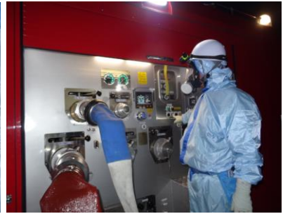
ポンプ起動操作（夜間）
