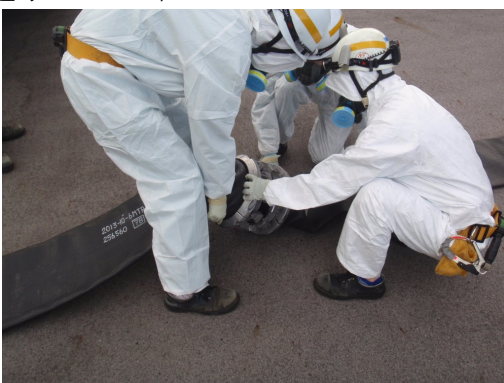
ホース接続作業
