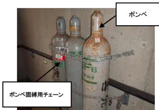
【3号炉ガス倉庫】
