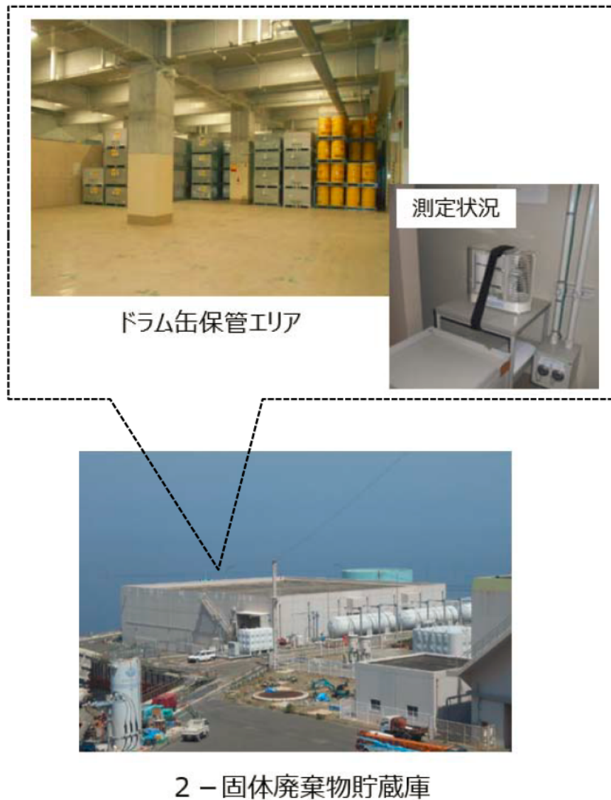
図2 建屋内温度の測定状況（2 - 固体廃棄物貯蔵庫）
