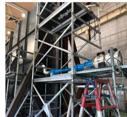
オペロBOP閉止装置気密試験状況
