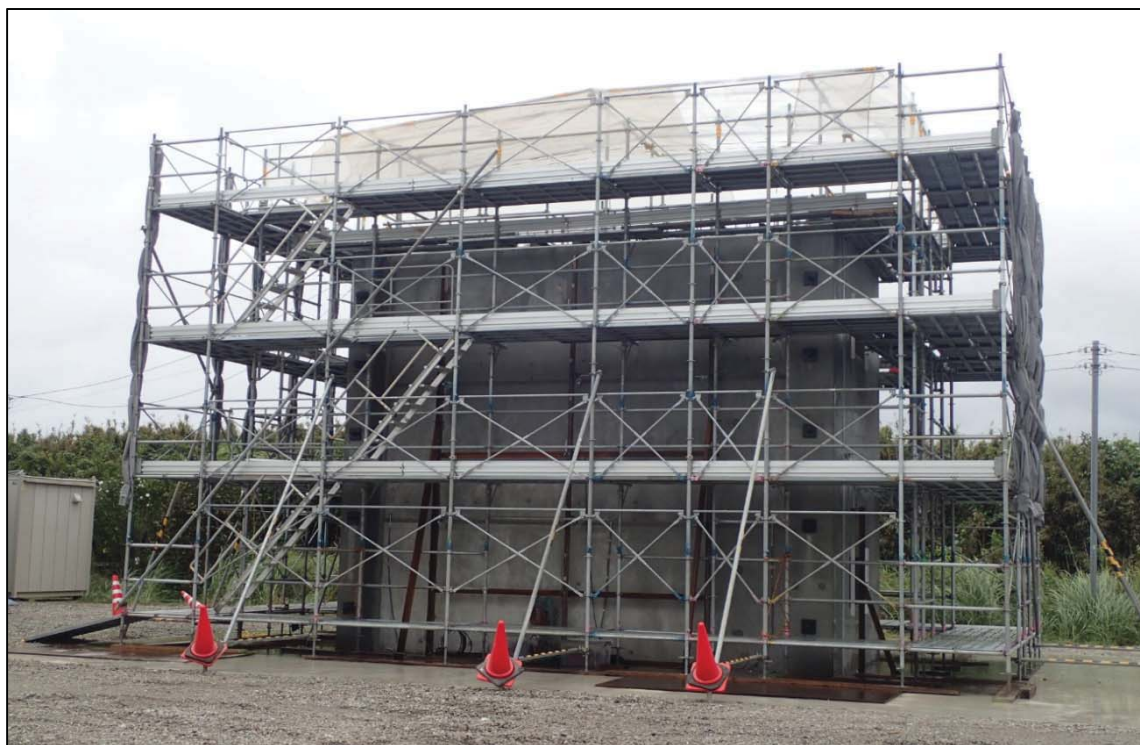
第21図 実証試験供試体の外観
