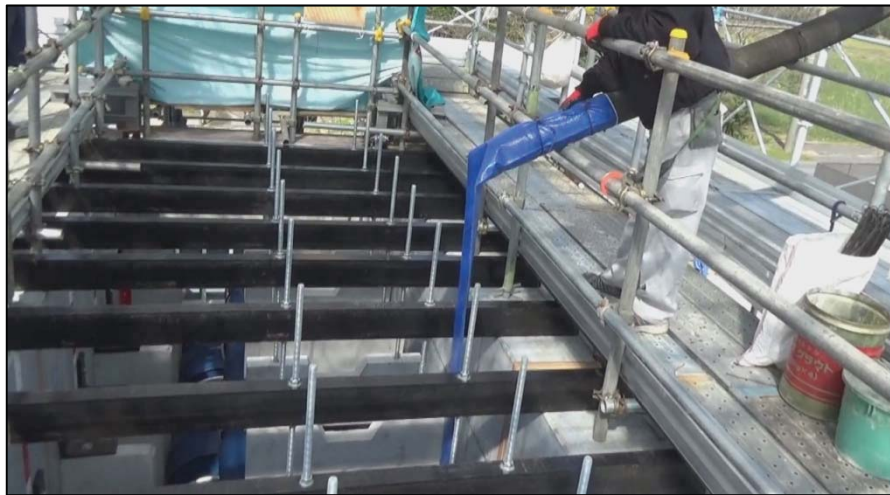
第 25 図 充填モルタル打込み状況
