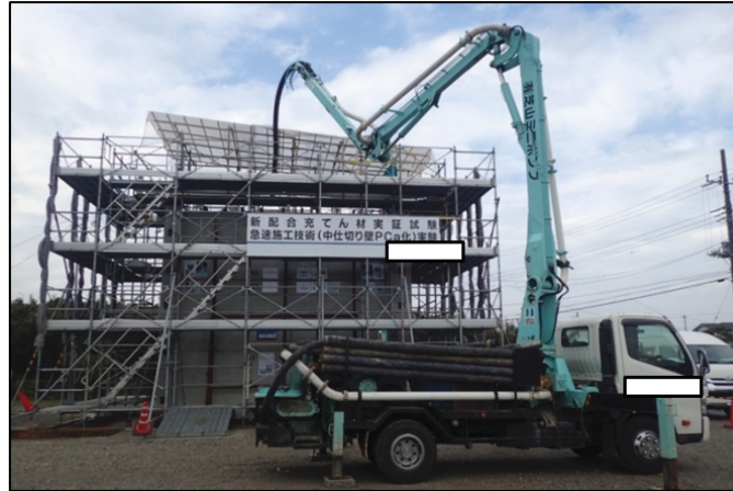
第 23 図 モルタル打設方法
