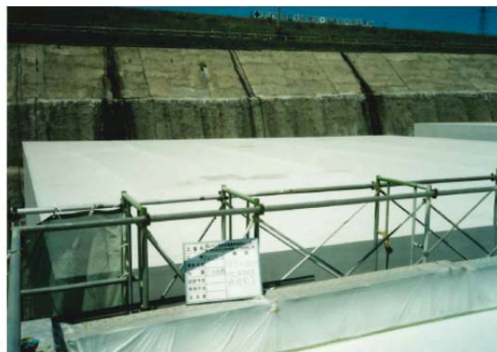
仕上げ材吹付け
