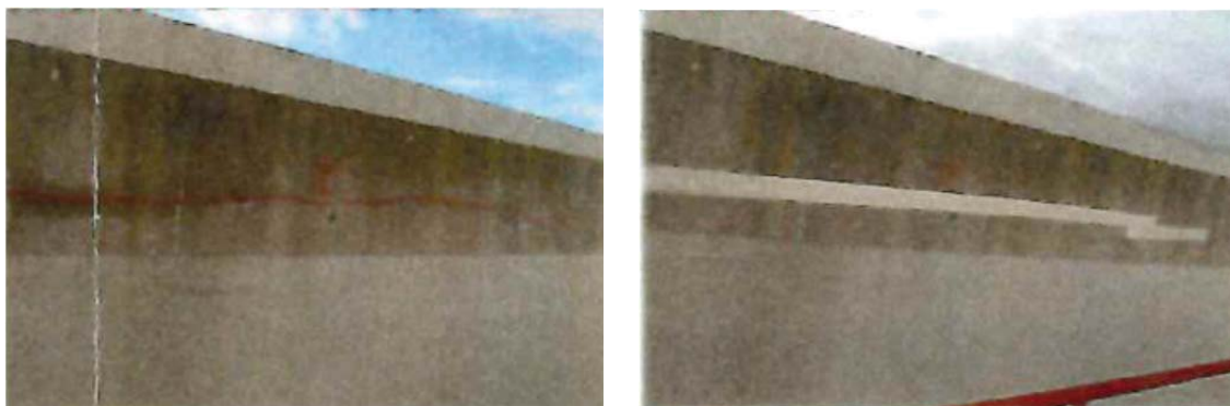
写真 9 表面止水工(1号 4-C 覆い側部)
