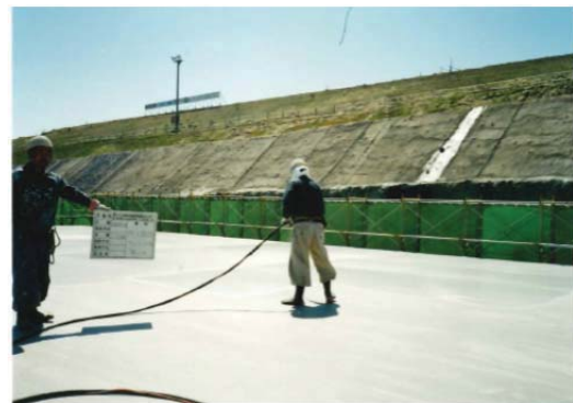
防水材吹付け
