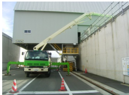
第4図 埋設設備内への充填材充填
