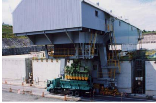
第1図 廃棄物埋設地における埋設クレーンによる吊上げ
