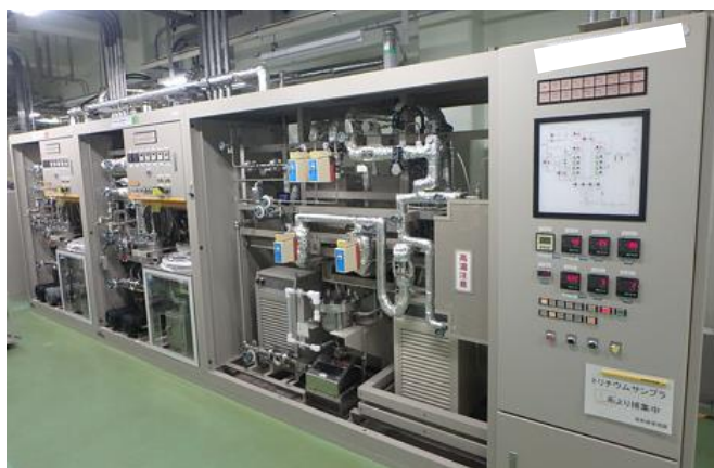
第 4 図 北換気筒（使用済燃料受入れ・貯蔵建屋換気筒）の 排気モニタリング設備の外観
