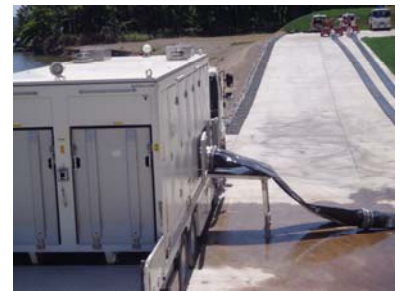
可搬型建屋外ホース接続 (300A)
