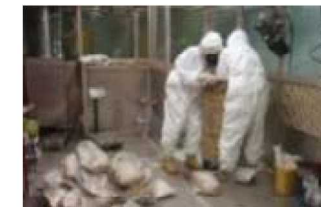
放射性廃棄物の取出し
