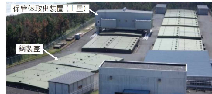
保管廃棄施設・Lの上空からの写真
