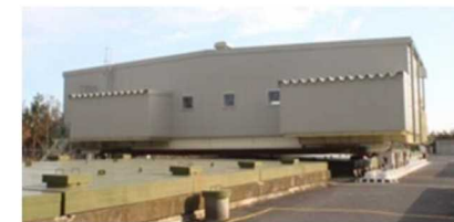
保管体取出装置（上屋）の例
