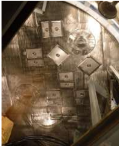
図3 コリウムシールド外観
