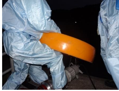
水中ポンプ設置準備（夜間）
