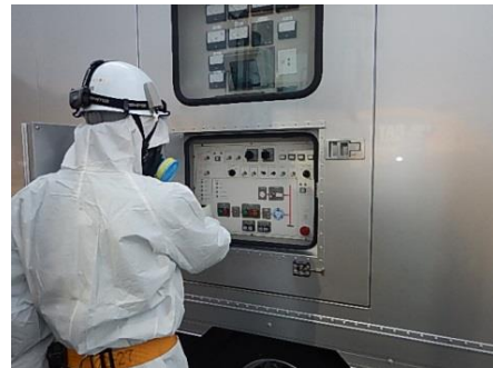
高圧発電機車での作業
