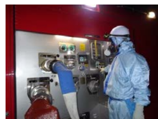
ポンプ起動操作（夜間）
