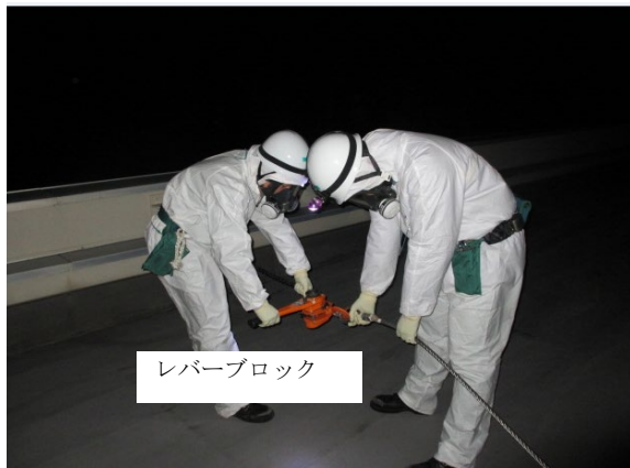
ワイヤー，レバーブロック接続作業
