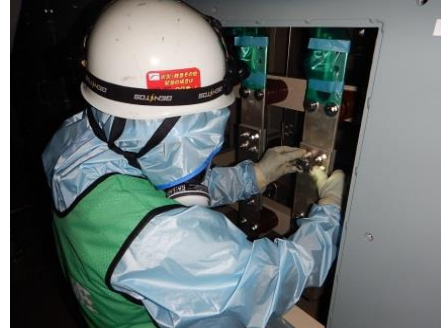
ボルトリンク接続作業
