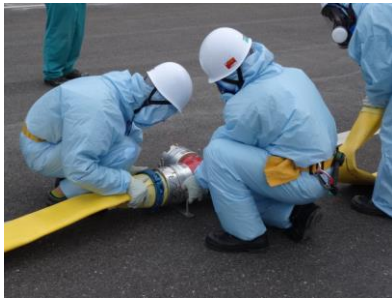
ホース接続作業（昼間）
