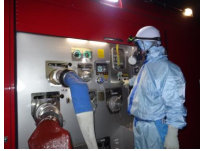
ポンプ起動操作（夜間）
