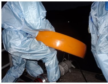
水中ポンプ設置準備（夜間）
