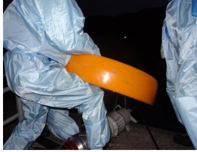
水中ポンプ設置準備（夜間）
