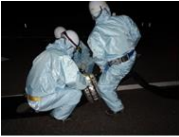
ホース接続作業（夜間）
