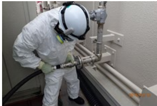
ホース接続作業
