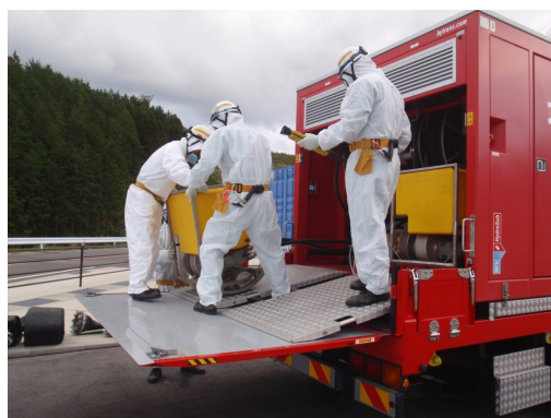
水中ポンプ設置準備
