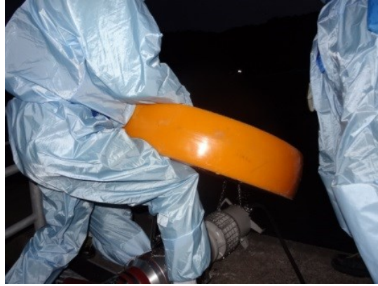
水中ポンプ設置準備（夜間）
