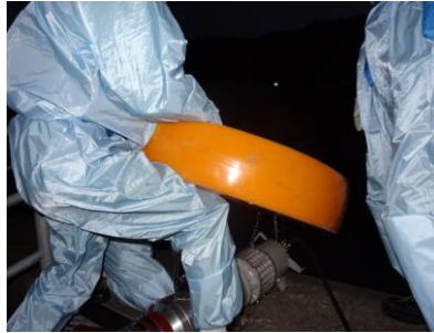
水中ポンプ設置準備 (夜間)
