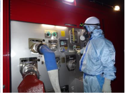
ポンプ起動操作 (夜間)
