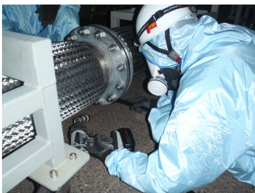
ホース接続作業
