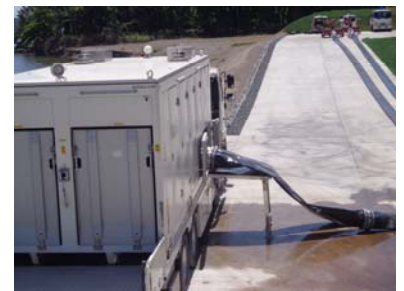
可搬型建屋外ホース接続 (300A)
