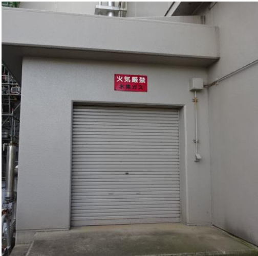
水素・炭酸ガスボンベ室
