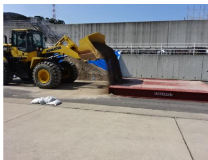
第6図 段差復旧状況
