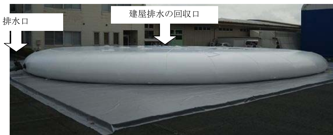
図3 可搬型排水受槽 全景 (イメージ)
