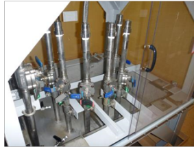
接続口 25A配管
