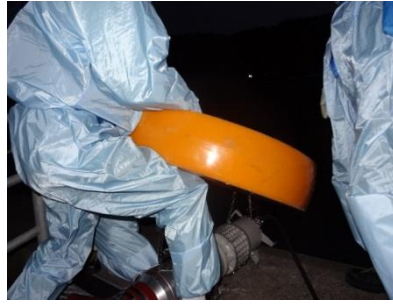
水中ポンプ設置準備（夜間）
