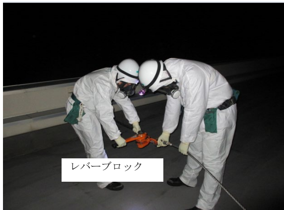
ワイヤー，レバーブロック接続作業
