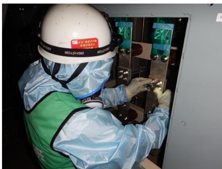
ボルトリンク接続作業
