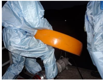
水中ポンプ設置準備（夜間）
