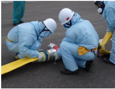
ホース接続作業（昼間）
