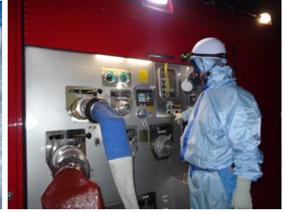
ポンプ起動操作（夜間）
