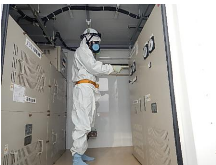
直流給電車での作業
