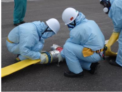
ホース接続作業 (昼間)
