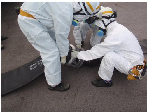
ホース接続作業
