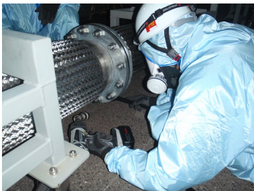
ホース接続作業
