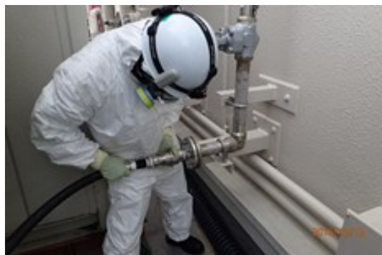
ホース接続作業
